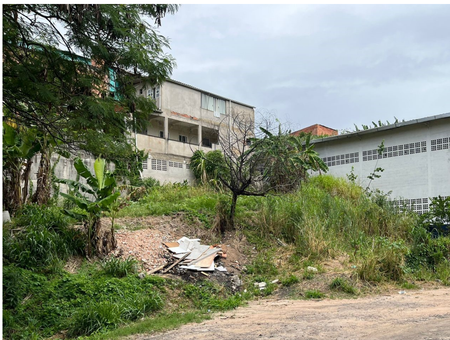
Foto 01: Vista da rua de acesso
