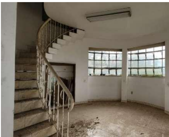
Figura 57 – Acesso ao terceiro pavimento
