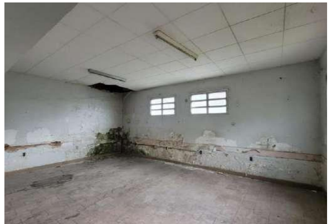
Figura 56 – Vista segundo pavimento
