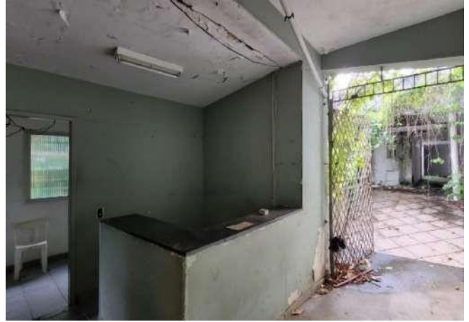
Figura 15 – Vista interna edificação
