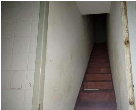
Figura 53 – Acesso ao segundo pavimento
