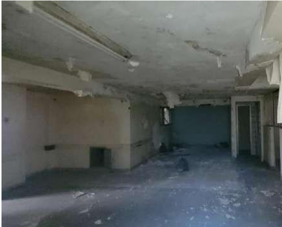
Figura 59 – Vista pavimento térreo
