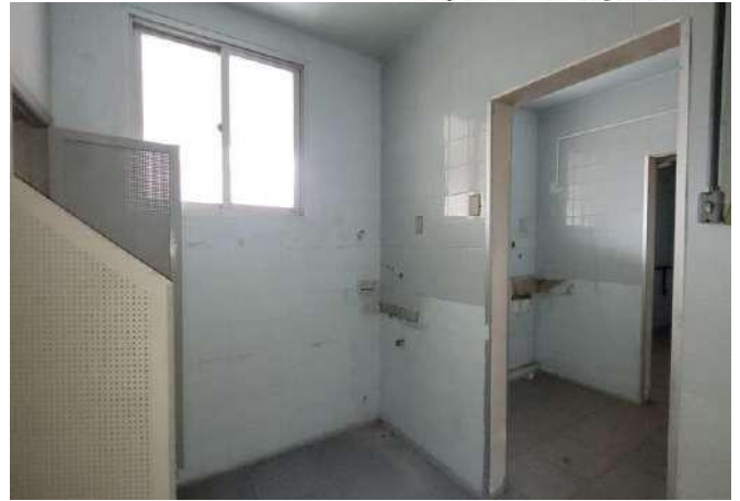
Figura 54 – Vista segundo pavimento
