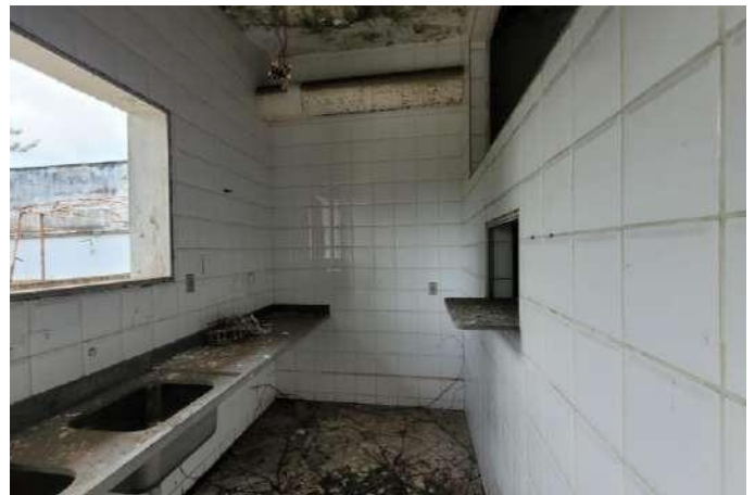
Figura 32 – Cozinha primeiro pavimento
