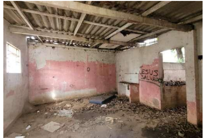
Figura 62 – Vista interna edificação 2
