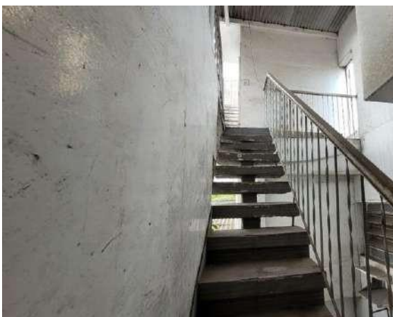
Figura 39 – Acesso ao terceiro pavimento
