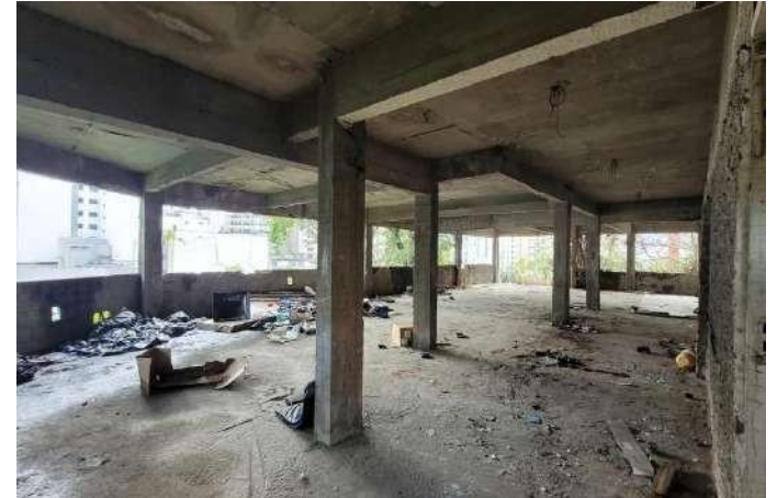
Figura 26 - Vista pavimento térreo
