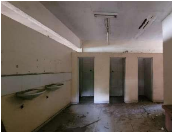
Figura 25 – Banheiro pavimento térreo
