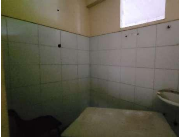
Figura 20 – Banheiro sala pavimento térreo
