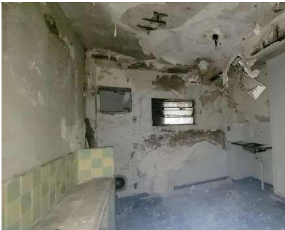
Figura 47 – Vista pavimento térreo
