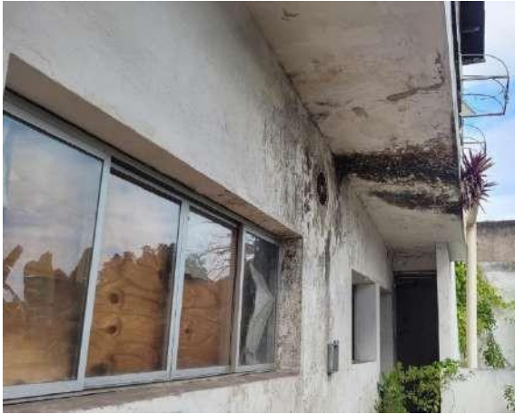
Figura 29 – Vista primeiro pavimento
