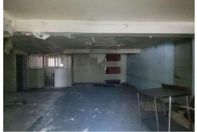
Figura 60 – Vista pavimento térreo
