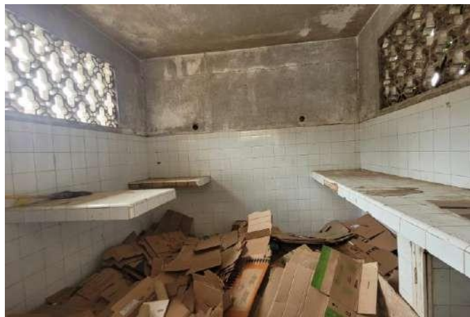
Figura 64 – Vista interna edificação 2
