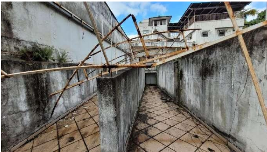
Figura 4 – Rampa de acesso ao 2º pavimento
