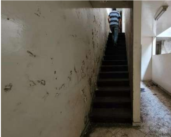
Figura 35 – Acesso ao segundo pavimento
