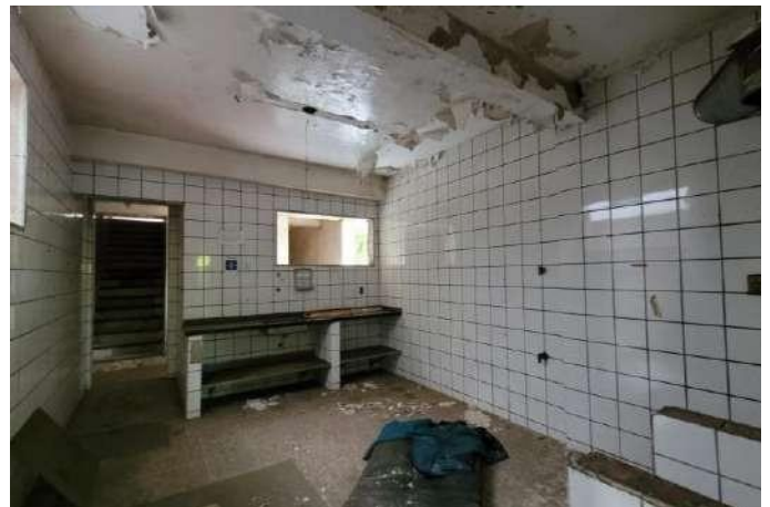
Figura 34 – Cozinha primeiro pavimento
