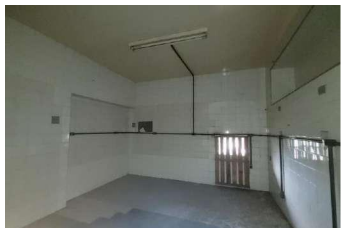
Figura 52 – Vista primeiro pavimento
