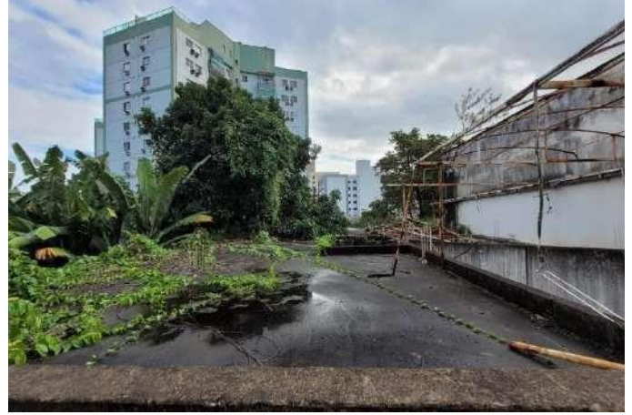
Figura 30 – Vista primeiro pavimento
