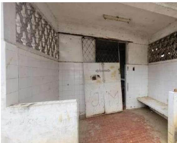
Figura 63 – Vista interna edificação 2
