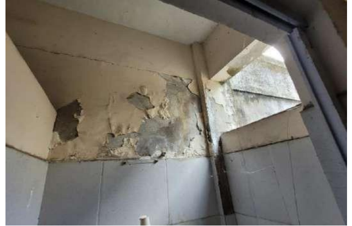
Figura 24 – Parede banheiro pavimento térreo
