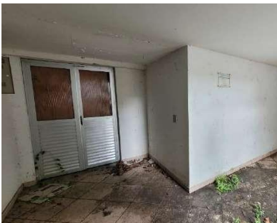
Figura 27 – Vista pavimento térreo
