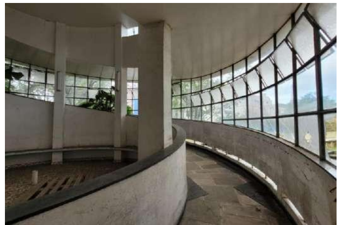
Figura 50 – Rampa de acesso aos pavimentos
