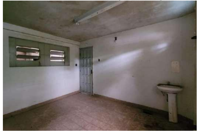
Figura 48 – Vista pavimento térreo
