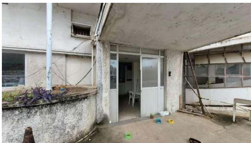
Figura 2 – Acesso ao pavimento térreo
