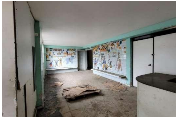
Figura 44 – Recepção pavimento térreo
