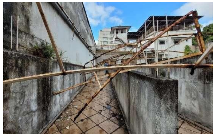
Figura 28 – Acesso ao primeiro pavimento
