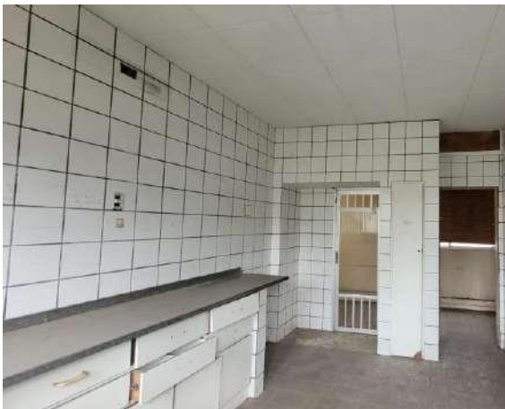
Figura 55 – Vista segundo pavimento
