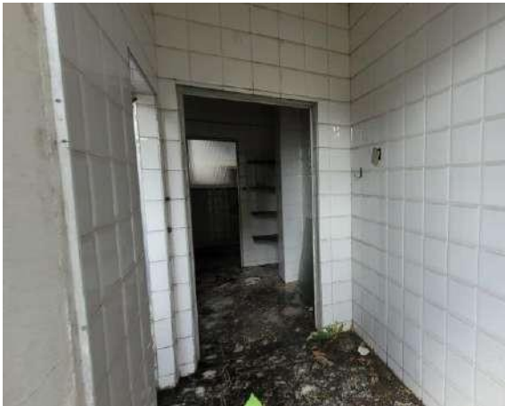
Figura 31 – Vista primeiro pavimento
