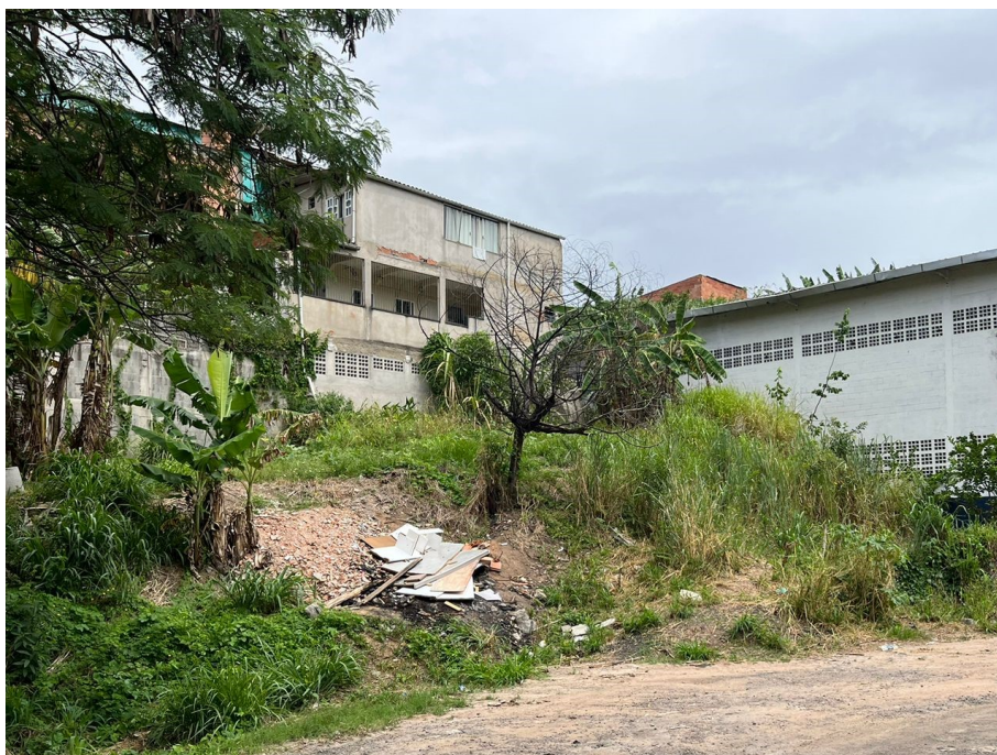
Foto 01: Vista da rua de acesso
