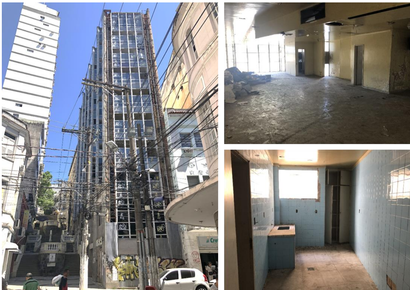
Figura 2 – Edifício Valia, com destaque para a fachada ao lado da Escadaria Maria Ortiz, e seu interior
